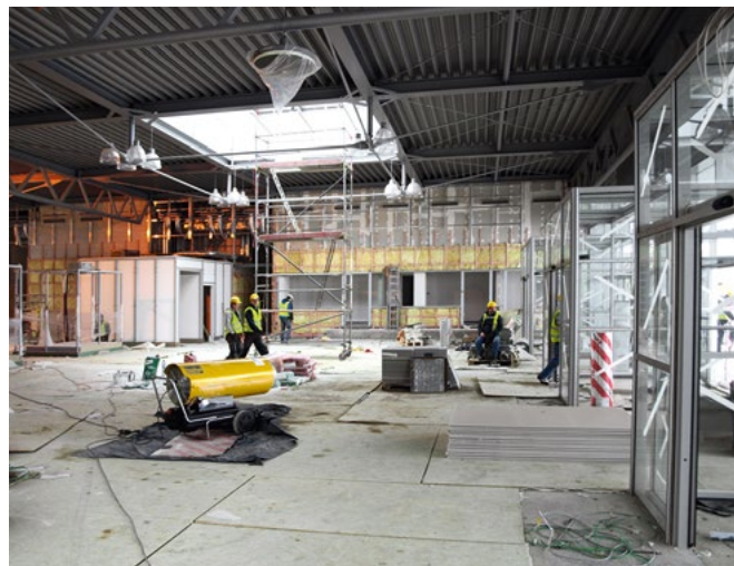
Master B 180 - na placu budowy
