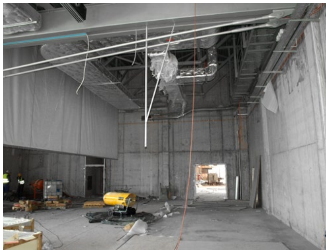
Plac budowy lotniska - Master B 360
